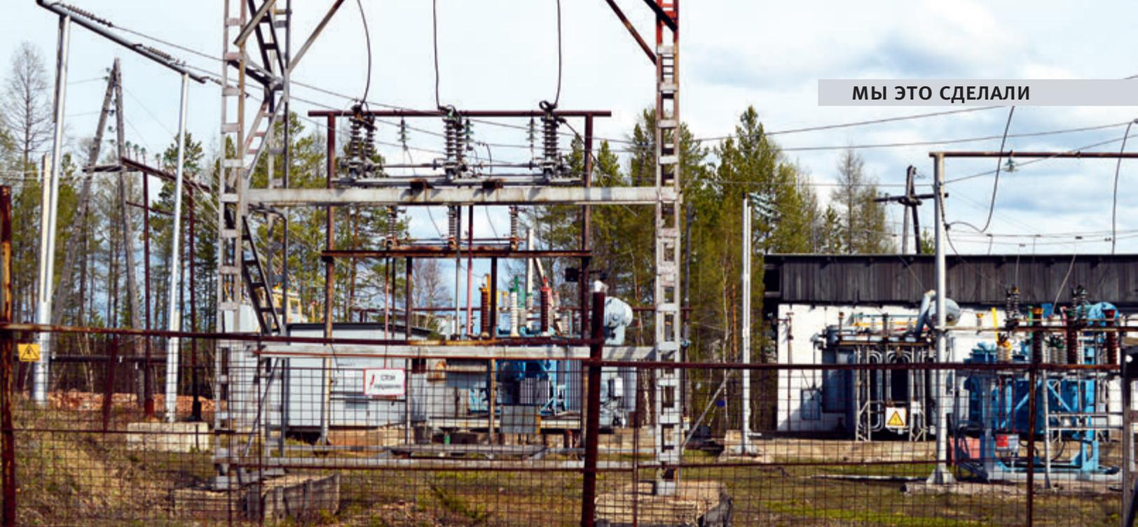
расстояний до ближайших населенных пунктов. Мощность двух установленных на подстанции трансформаторов составляет по 10 МВА.
