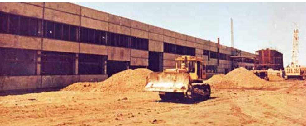
Строительство ОВК БТЭЦ, 1982 г.
