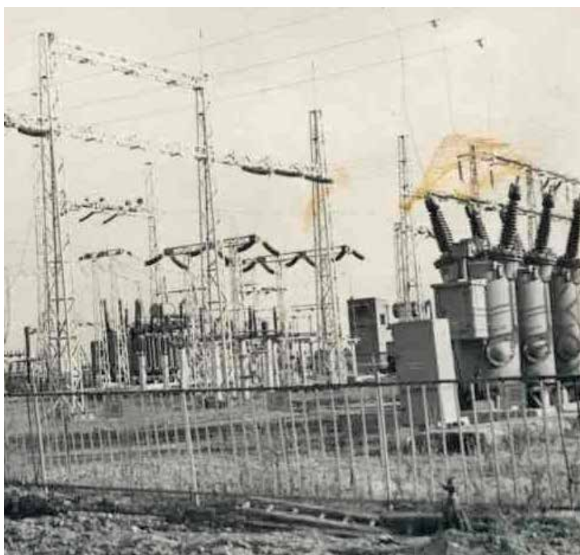
Скоро и это распределительное устройство 110 кВ поставят под напряжение.
