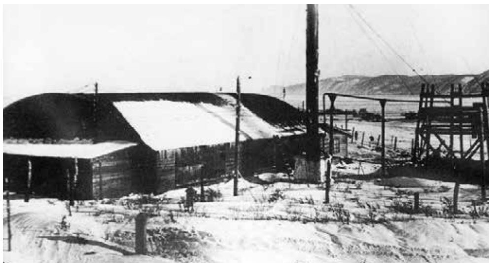
Временная электростанция Комсомольска мощностью 250 кВт
