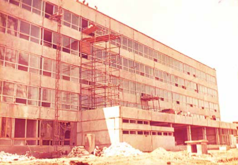
Строительство главного административного здания, 1982 г.
