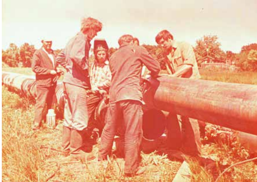
Монтаж золопровода, 1982 г.
