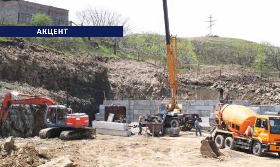
ПС «Орлиная». Начало строительства
