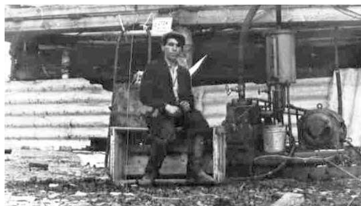
Закончилась сушка автотрансформатора 220/110/6 кВ. Идет заливка масла. Следить за заливкой поручено В.Л. Гобису.
