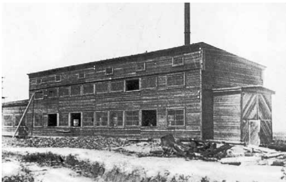
Первая электростанция на Дземгах
