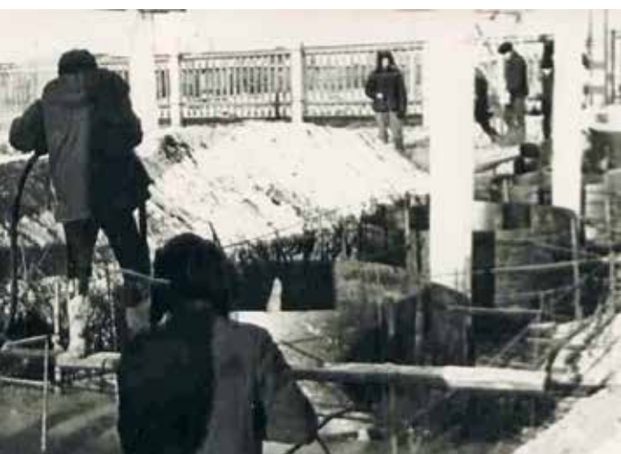
Подстанция 220 кВ «Биробиджан». Ведутся монтажные работы. Готовят котлованы для фундаментов под высоковольтное оборудование.
