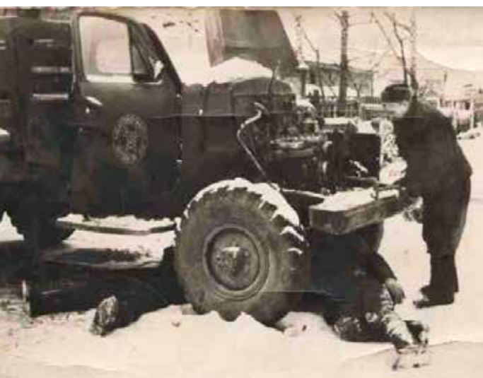
Начинает появляться техника. Гаража пока нет, и ремонт производился вот так.
