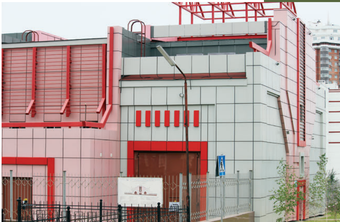
ПС «Городская» 110 кВ, г. Хабаровск. 2016 год
