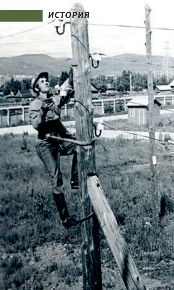
ЛЭП 04 кВ. Космосомольский район, 60-ые годы
