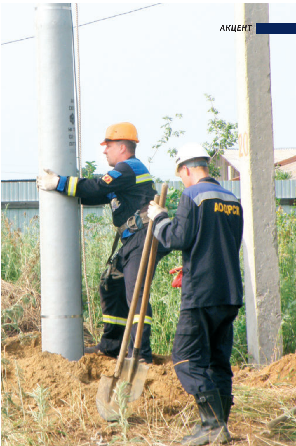
Установка композитных опор с. Волково Амурской области
