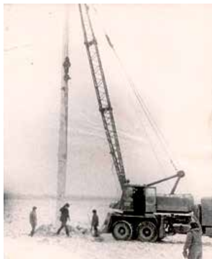
Установка железобетонных опор в районе с. Сергеевка Хабаровского района
