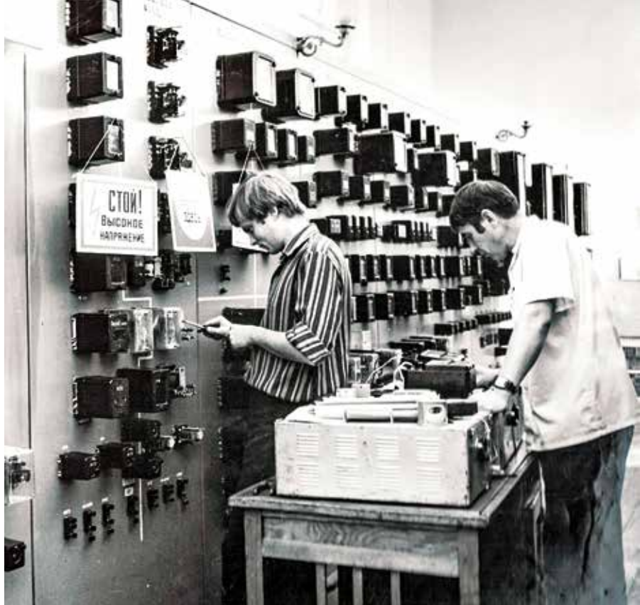
Комплексный ремонт подстанции «Береговая - Насосная»
