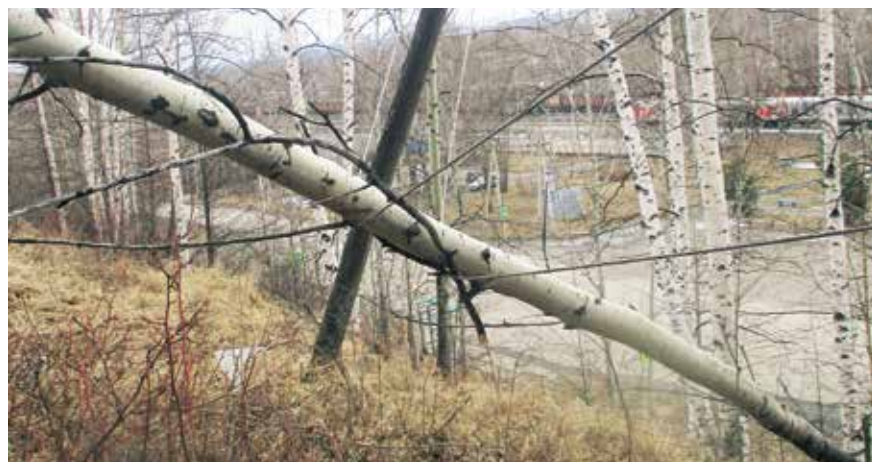
ВЛ бесхозная на 4 дома в момент повреждения
