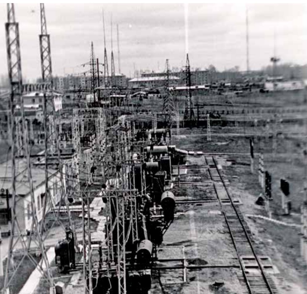
Подстанция 220 кВ «РЦ» (г. Хабаровск)
