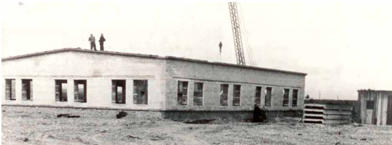
Строительство подстанции 220 кВ «Биробиджан»
